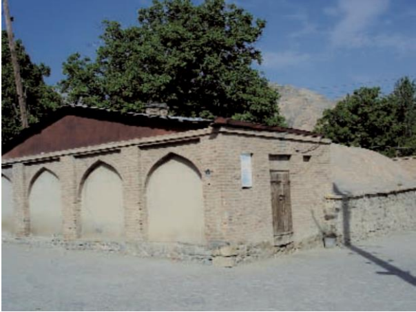
Foto- 13. Buzxana binası
